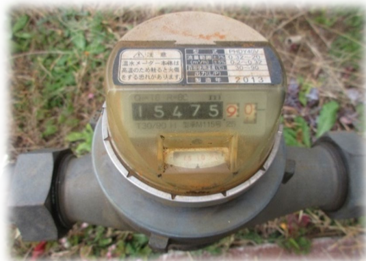
C 棟前のメーターでは少しずつ流量が見られます
